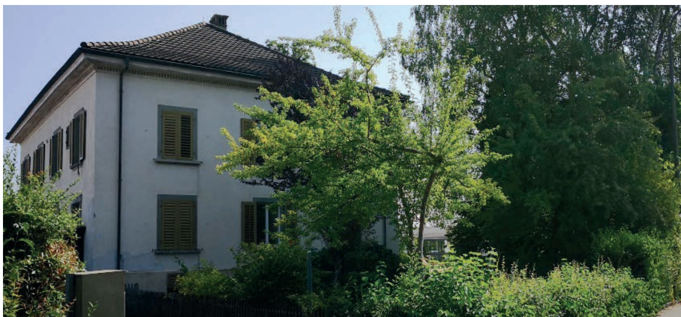
Maurstrasse 25, aktueller Zustand
