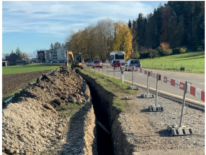
Ersatzneubau Pumpwerk und Pumpendruckleitung, PW Wisbach, Fällanden
