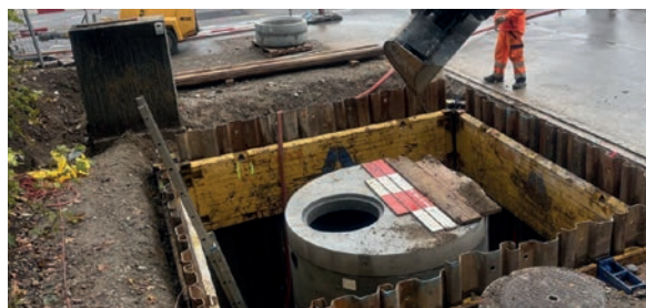
Ersatzneubau Pumpwerk und Pumpendruckleitung, PW Wisbach, Fällanden: 3D-Modell Pump- und Armatureschacht. Der Schacht wurde aus vorgefertigten Schachtbauteilen erstellt. Die gesamte Pumpendruckleitung wurde ersetzt und in grösserer Dimension neu ausgeführt.
