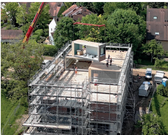
Montage der Holzmodule
