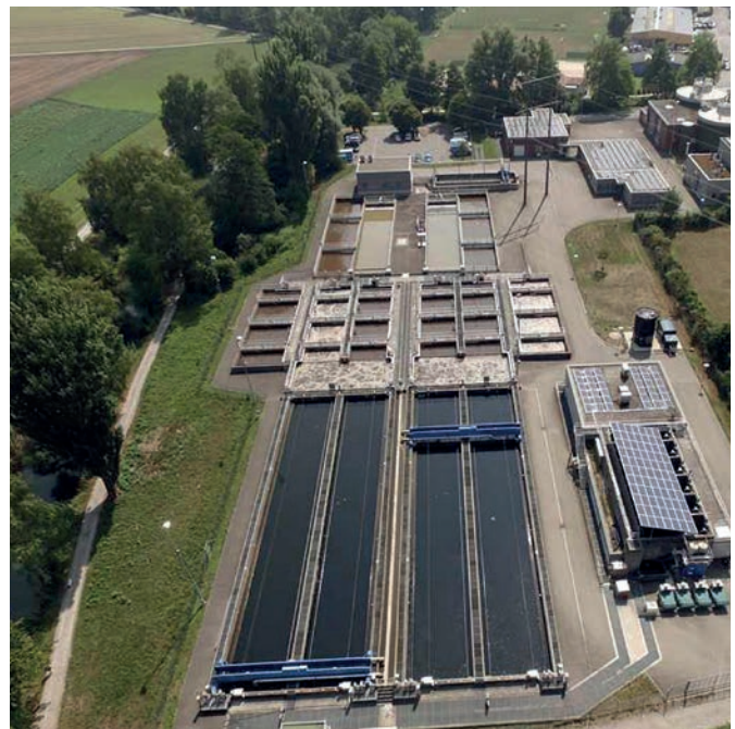
Luftaufnahme der Kläranlage Bachwis, Foto: Zweckverband Kläranlage VSFM
