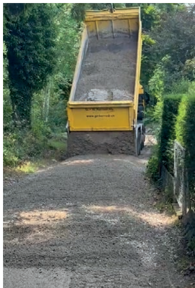
Instandsetzung Jörenbachweg, Benglen
