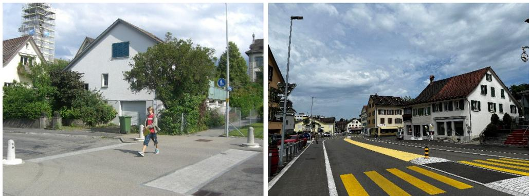
Abbildung 40: Querungshilfen vertikaler Versatz in Oberrieden (links) und Schutzinsel mit Fussgängerstreifen in Hinwil (rechts)
