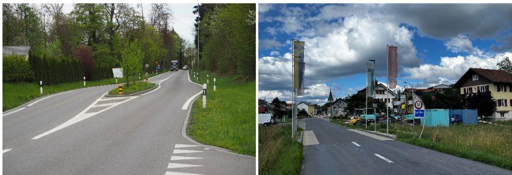
Abbildung 48: Eingangspforte mit Mittelinsel in Fischbach-Göslikon (links) und dezentler mit Kandelaber und Markierung in Le Lieu
