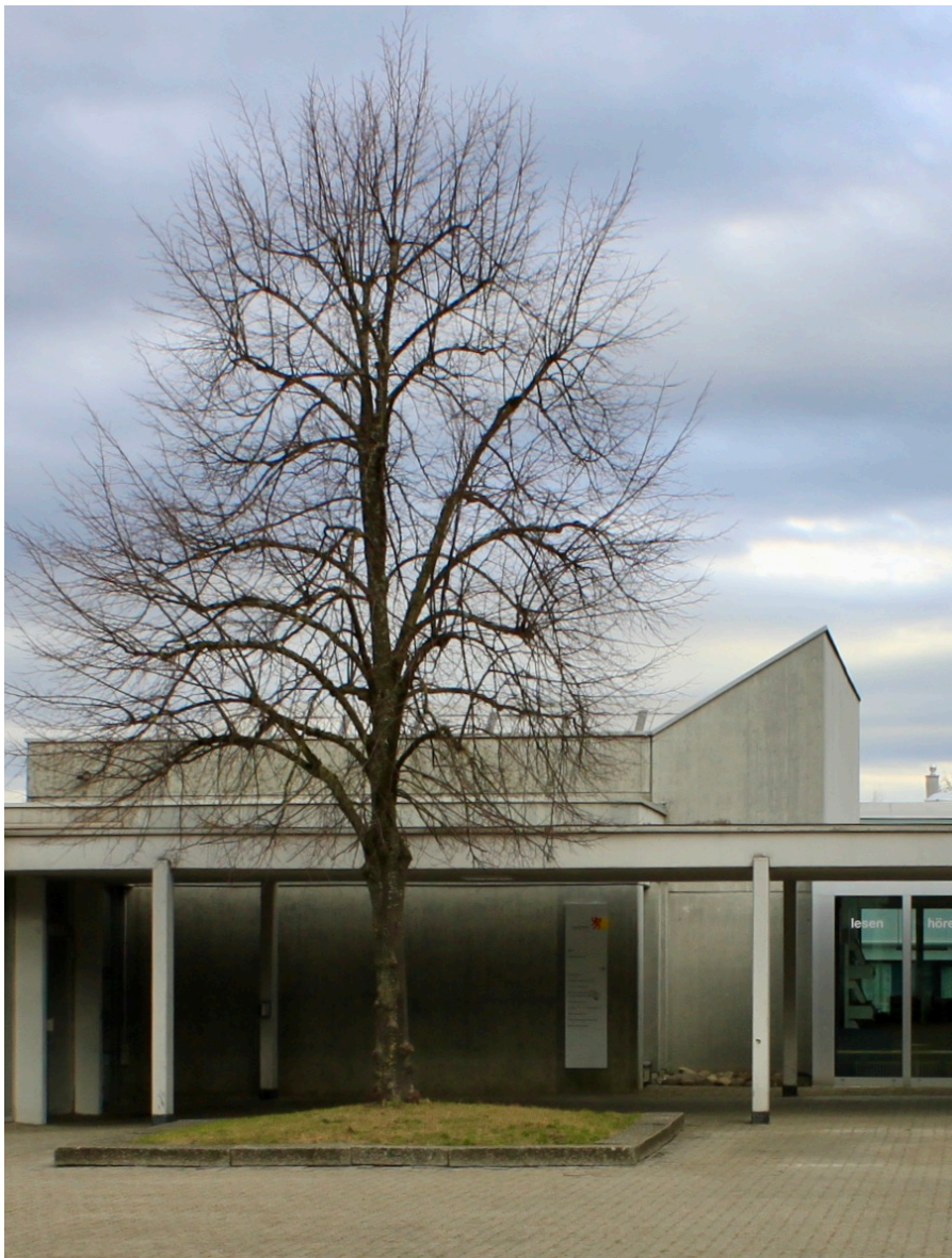
Turmwirkung des Pultdachs vom Gemeindesaalbau, Südwestansicht
