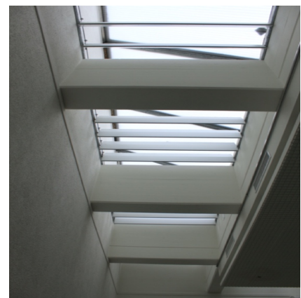
Dachlichtband über Betonträgern
