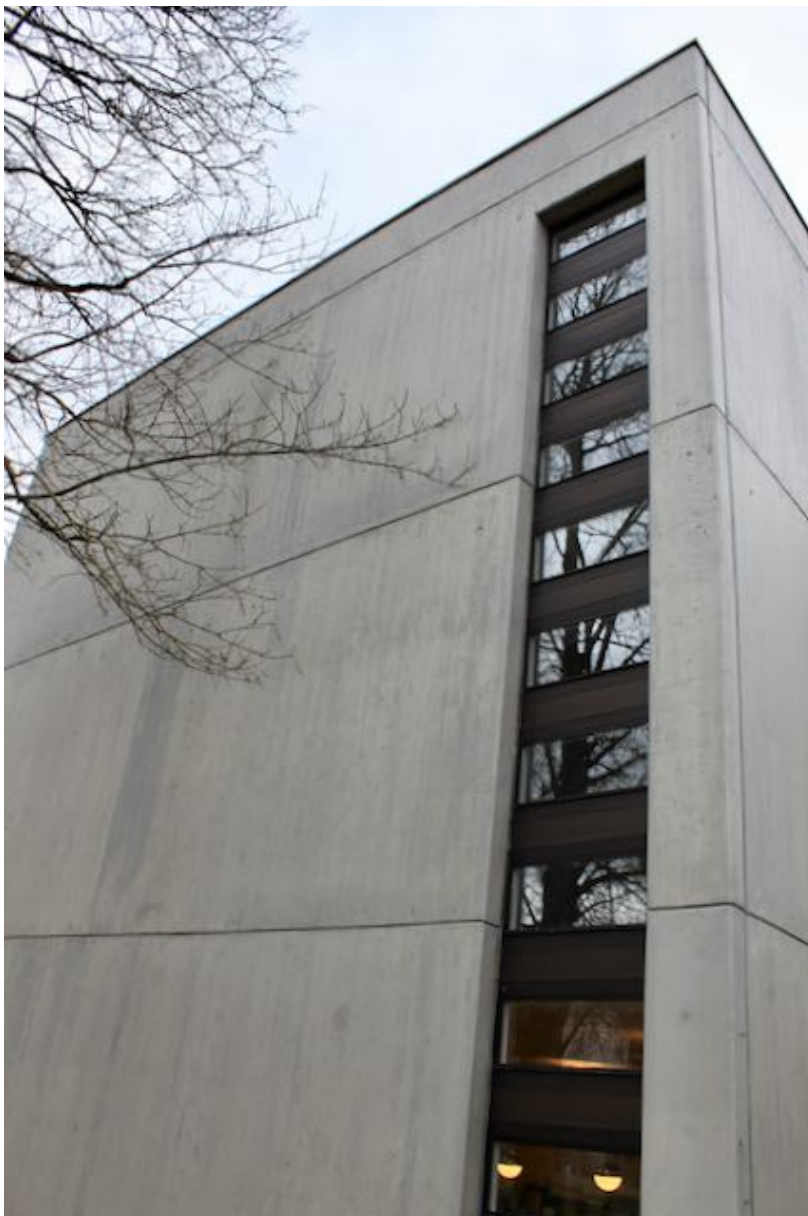
Vertikales Lichtband in Sichtbetonfassade
