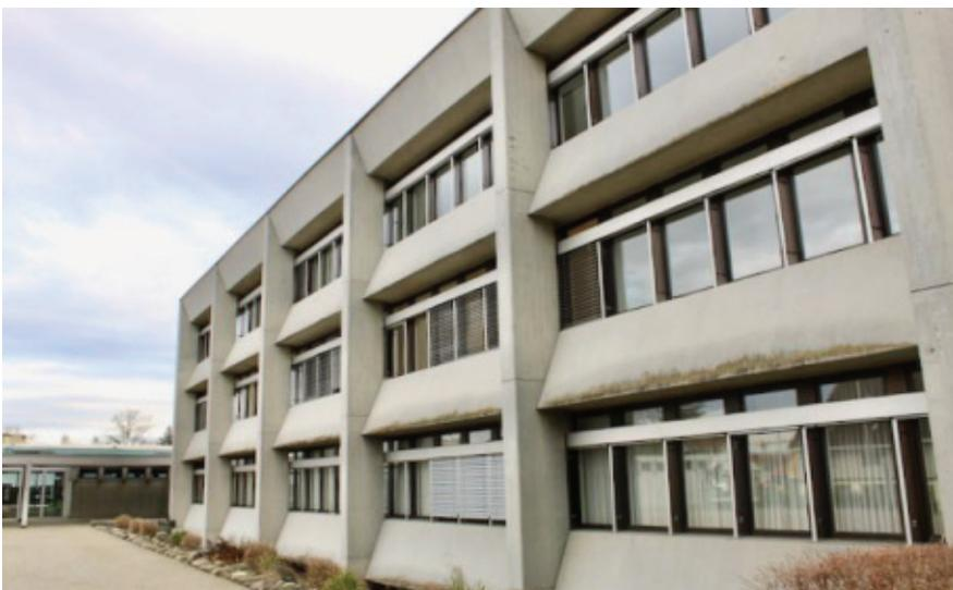
Nordwestfassade des Verwaltungsgebäudes mit vortretenden vertikal ausgerichteten Betonrippen & langgestreckten horizontalbetonten Fensterbändern
