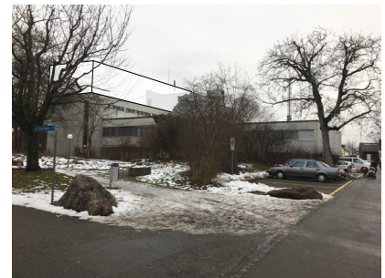
Aufstockung Stüdost Trakt
