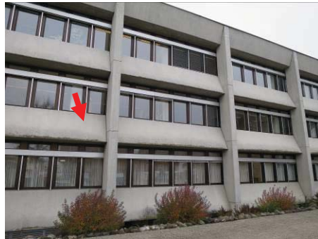
Fensterstürze an Fassade
