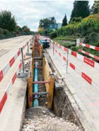
Rohrleitungsbau Wasserversorgung, Pfaffensteinstrasse, Pfaffhausen.
