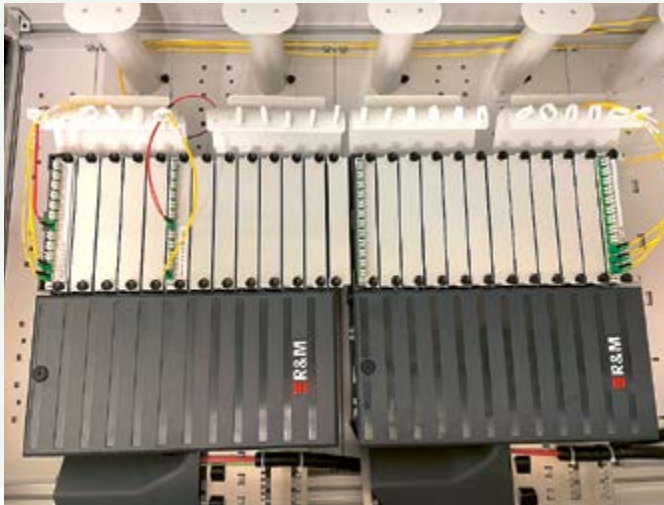
Fiberoptic Spleiss- und Rangiereinheit mit 288 Faserverbindungen.
