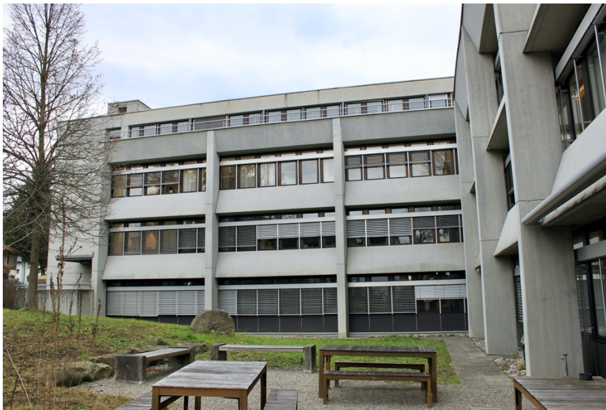
Ansicht Südwest, Haupttrakt des Verwaltungsgebäudes
