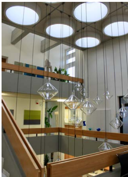
Atrium mit Oberlichtbeleuchtung
