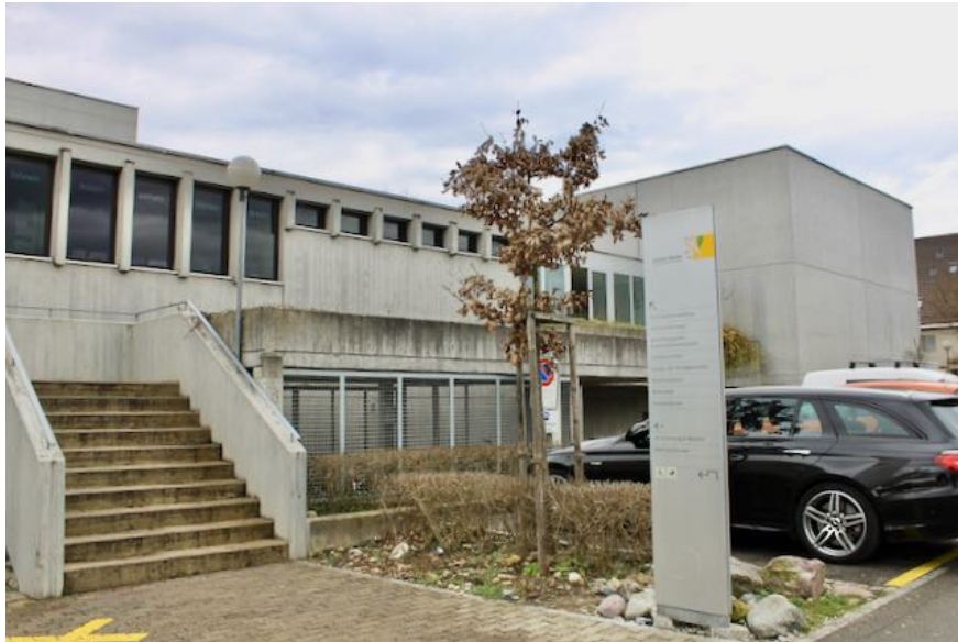
Bibliotheksgebäude mit Treppenaufgang zum Gemeindehausplatzniveau, rechts geschlossener Baukubus des Gemeindesaals
