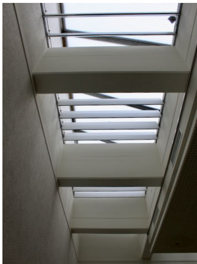
Dachlichtband über Betonträgern
