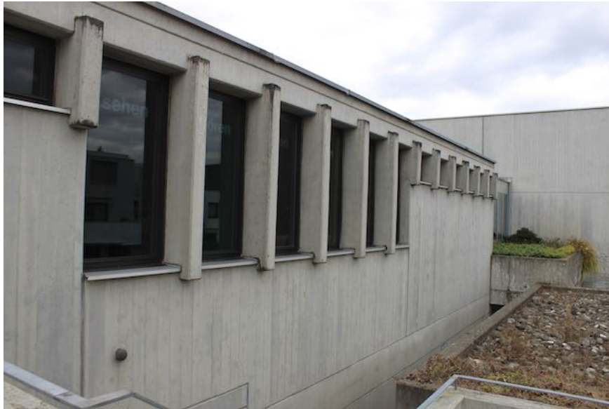
Hochformatige & schmale horizontal gelagerte Fensterbänder mit vorgestellten gliedernden Betonstegen
