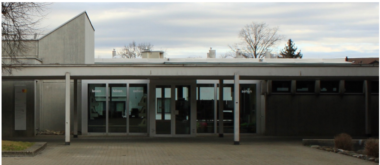
Südwestfassade der Bibliothek
