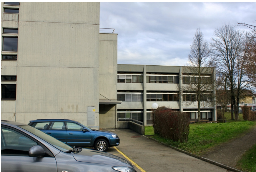
Ansicht Südost, Nebentrakt des Verwaltungsgebäudes
