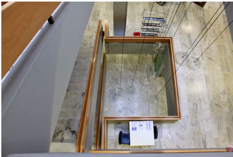
Treppenanlage mit rechteckigem Treppenauge
