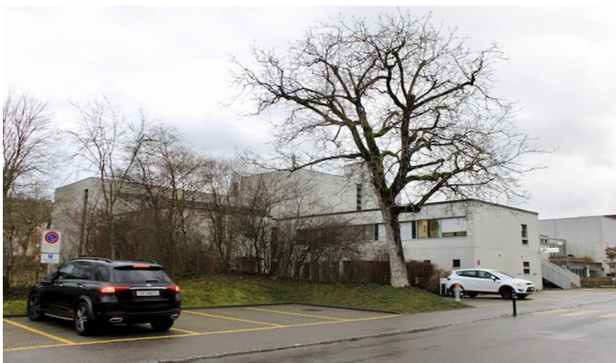
Nordostfassaden von Polizeiposten und östlichem Verwaltungstrakt
