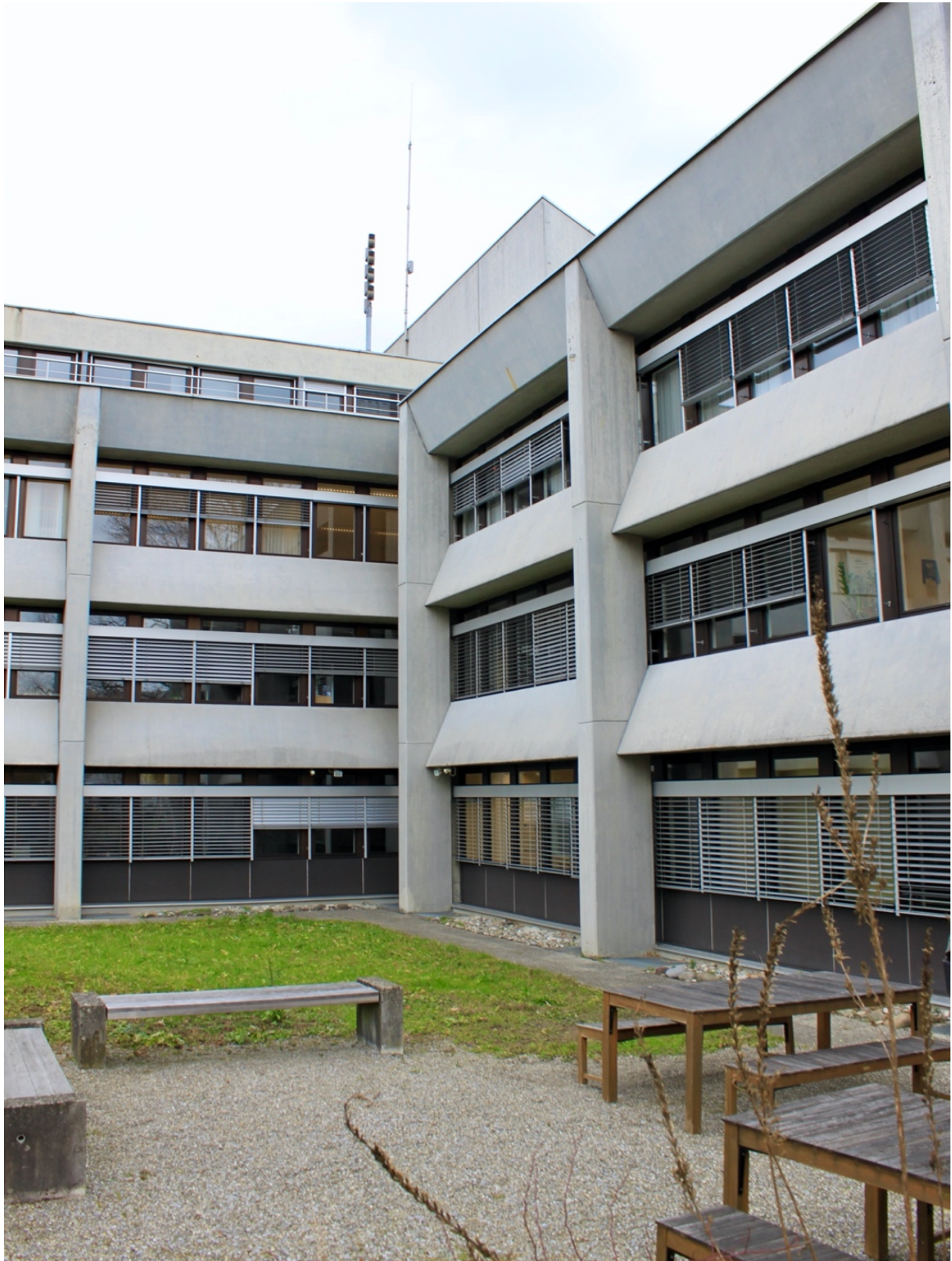
Ansicht Süd, Nahtstelle von Haupttrakt & Neben-trakt des Verwaltungsgebäudes
