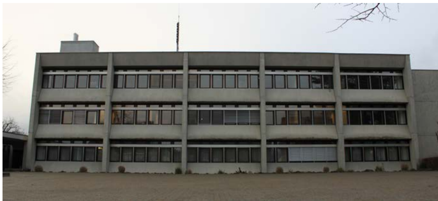
Ansicht Nordwest, dreigeschossiges Verwaltungsgebäude des Gemeindehauses (Bildmitte) & niedrigeres Bibliotheksgebäude
