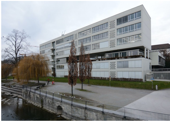
Hauswirtschaftsschule Wipkingen (Wipkingerplatz 4, Zürich), 1961
