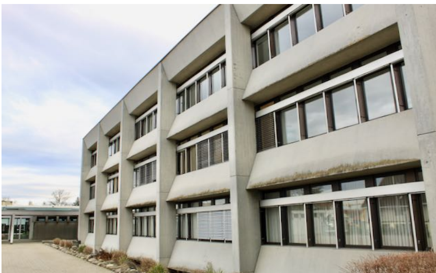
Nordwestfassade des Verwaltungsgebäudes mit vortretenden vertikal ausgerichteten Betonrippen & langgestreckten horizontalbetonten Fensterbändern
