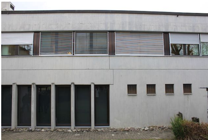
Diverse Fensterformate an Ostfassade Polizeiposten EG, Arrestzellen & Mehrzweckraum UG
