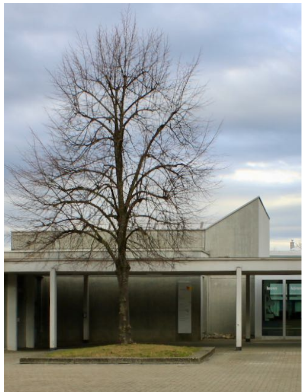
Turmwirkung des Pultdachs vom Gemeindesaalbau, Südwestansicht
