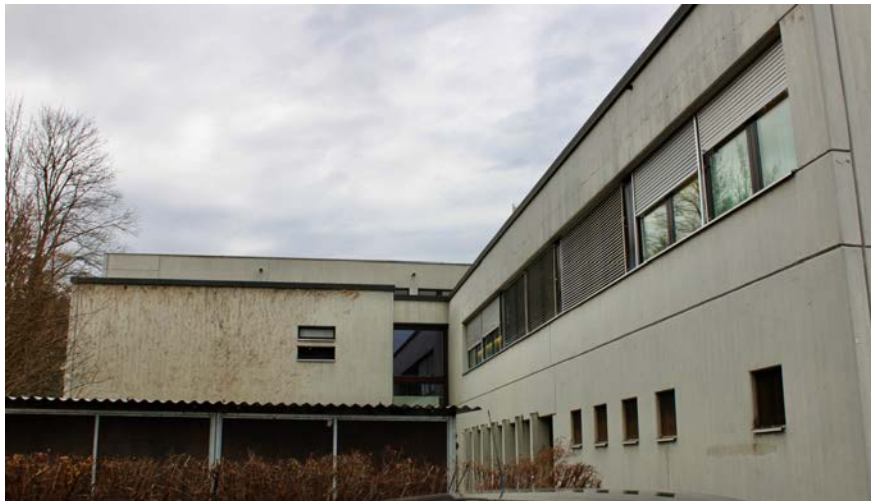
Ostfassade Polizeiposten & Mehrzweckraum UG, hinten
