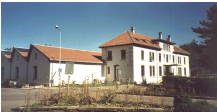
Sicht Ecke Wigartenstrasse - Sunnetalstrasse
